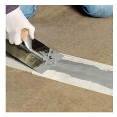
Résine souple d'étanchéité, qui se mélange au ciment pour former un mortier à haute capacité de déformation, permettant la réparation des fissures actives et la réalisation de joints de dilatation. Il présente une excellente compatibilité avec tous les types de ciment, afin de garantir mélange sans grumeaux. Il augmente la résistance à l'eau et à la fissuration pour les travaux de cuvelage, et assure la durabilité de vos réparations.
